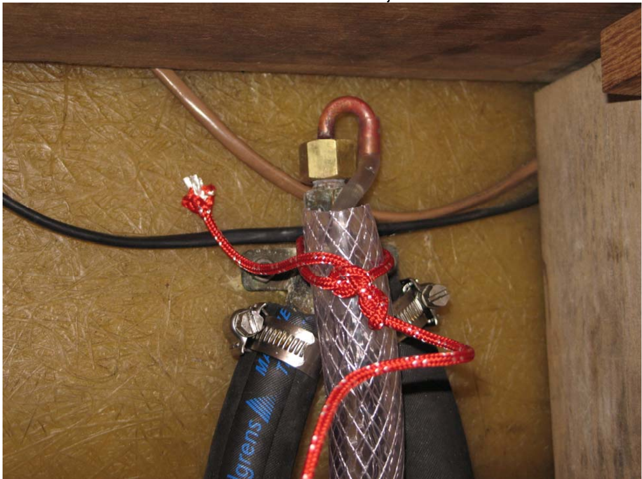
Bild 5.11, "ombyggd" vakuumentil i NF SWE 351
