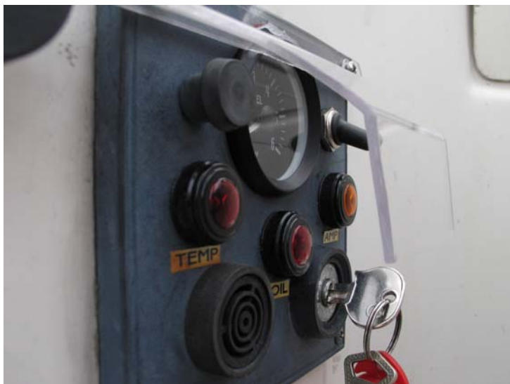
Bild 4.1 renoverad motorpanel i sittbrunnne med "trampskydd", nya lamphållare, ny vippströmbrytare för att styra magnetiseringsströmmen. Är man osäker på hur man ska bete sig med vippströmbrytaren, lämna den som på bilden (ned) så laddar alltid generatoren.
